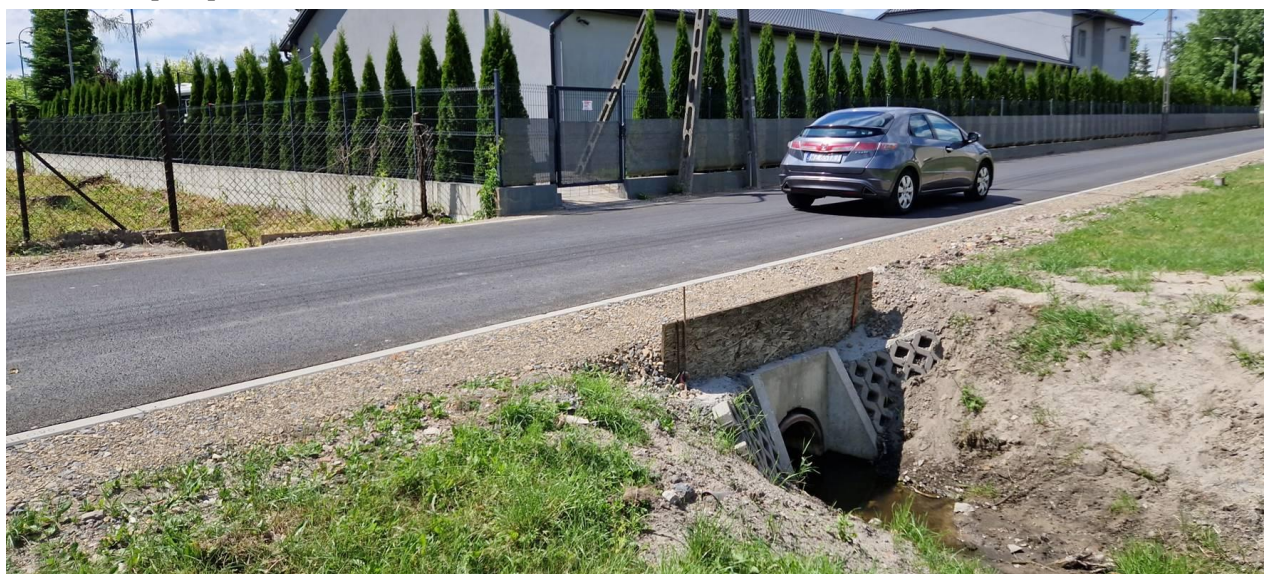
Fot. 8 - Przepust pod ulicą Rakową.
