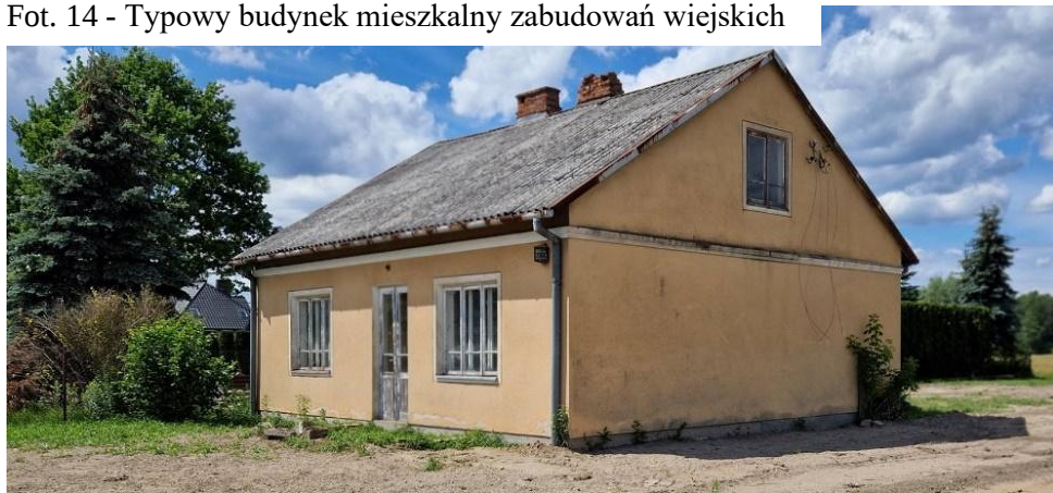
Fot. 14 - Typowy budynek mieszkalny zabudowań wiejskich
